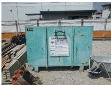
工事現場廃棄物保管所
